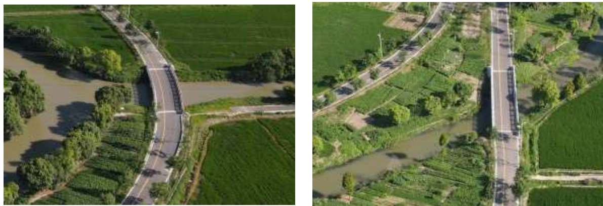
桥梁及驳岸工程区
