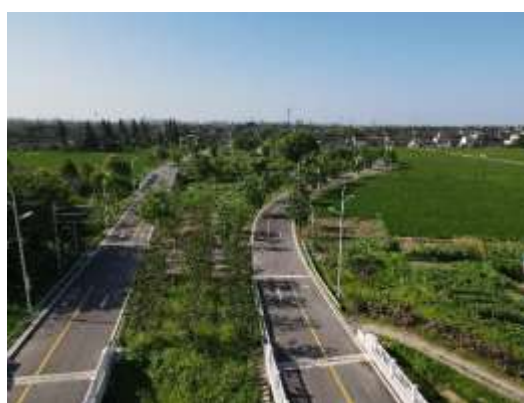
临时生产区绿化恢复
